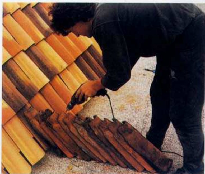
Si forano i coppi vecchi per riutilizzarli col sistema d'aggancio brevettato Molinà.
