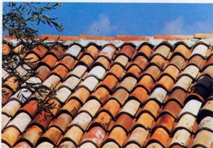
Si forano i coppi vecchi per riutilizzarli col sistema d'aggancio brevettato Molinà.
