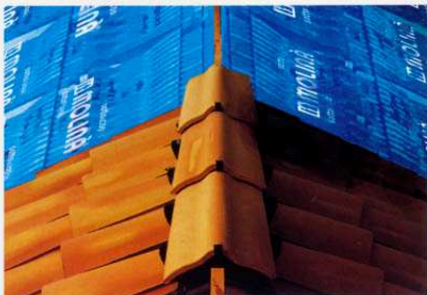
Colmo Aer-Tec applicato su un tetto isolato con ISO-SCOTCH la tegola isolante, gigante, vestita.
