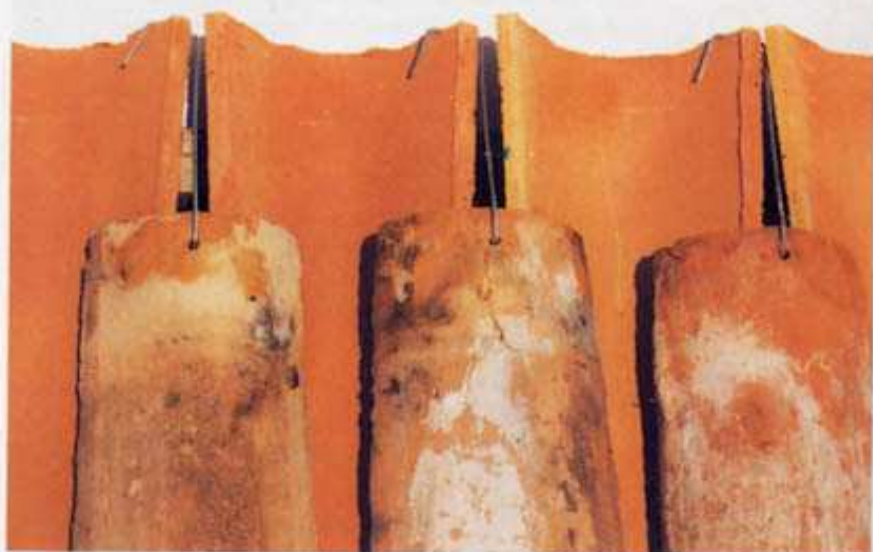
Sistema d'aggancio brevettato Molinà con coppo canale nuovo e coppo copertina antico.
